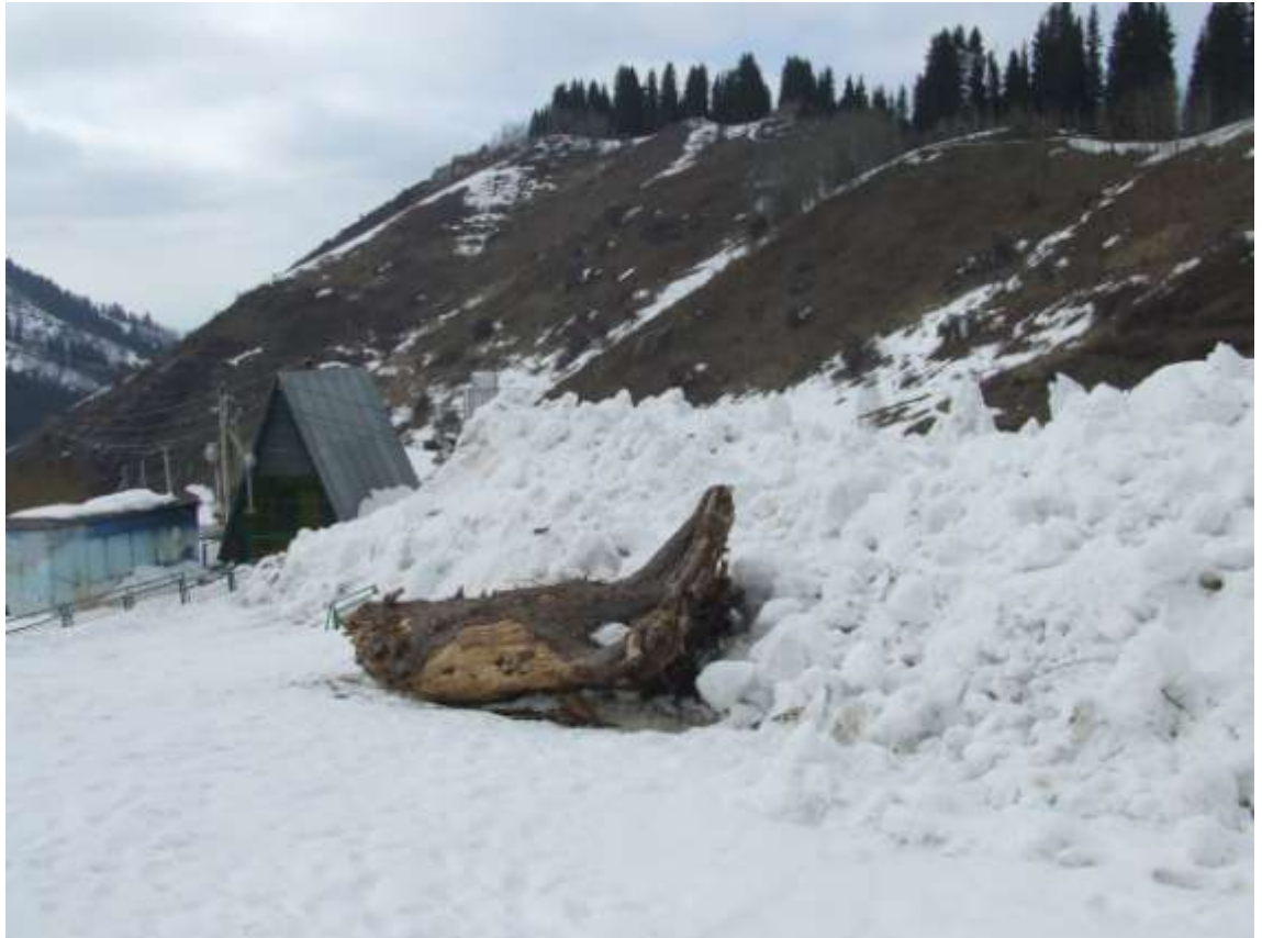
Рис.2. Снежная лавина, разрушавшая канатную дорогу на турбазе Алма-Тау (Алматинская область, Талгарский район)
